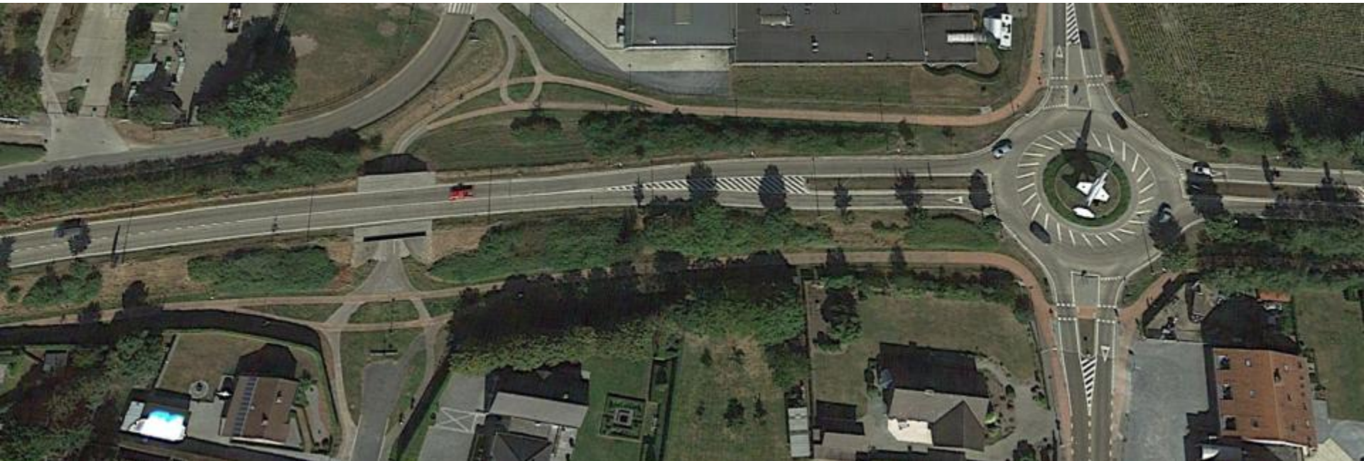
Foto: N73 te Peer (Limburg) met tunnel en rotonde
