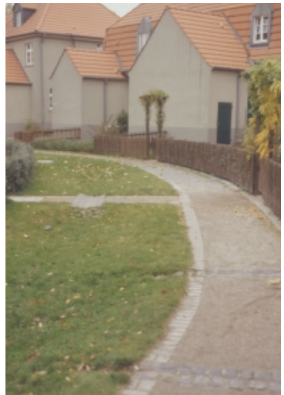
Foto 5 Gelsenkirchen (D. woonwijk Schüngelberg). Bij de renovatie van deze voormalige mijnwerkerswoningen is regenwater losgekoppeld van de riolering. Regenwater wordt via gootjes naar de wadi gebracht, waar het regenwater infiltreert in de bodem.
