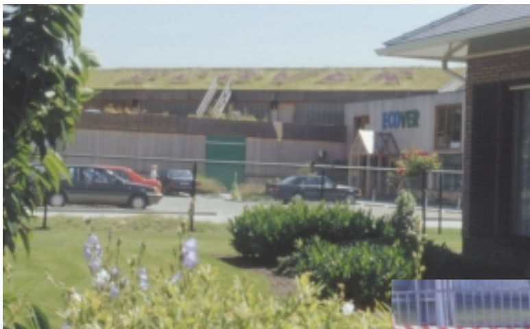
Foto 1 Malle (B): De fabriekshal van 'Ecover' kreeg een vegetatiedak, waarin de naam van het bedrijf door planten leesbaar is gemaakt.
