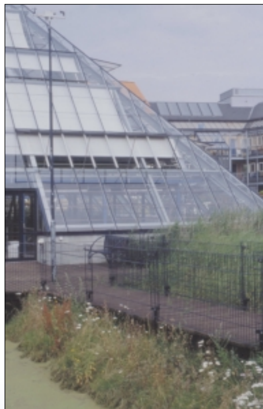
Foto 8 Kolding (DK). In die binnentuin werd ook een glazen piramide gebouwd waarbinnen afvalwater wordt gezuiverd door moerasplanten.
