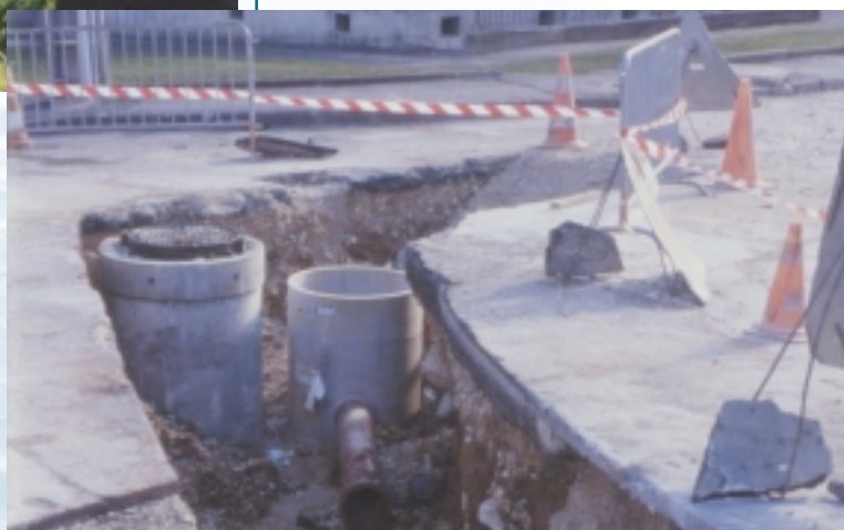
Foto 2 Belfort (F): Bij een grondige renovatie van een woonbuurt uit de jaren 1960 is de riolering gescheiden aangelegd: regenwater wordt gescheiden afgevoerd, zwart + grijs water ook.
