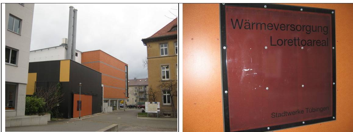
Tübingen (D). In de ecowijk Lorettoareal staat een WKK-centrale die de hele woonwijk van warm water voorziet via stadsverwarming. Foto's door Erik Rombaut.
