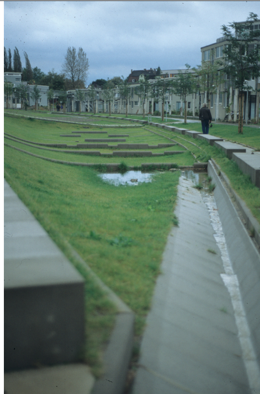
Gelsenkirchen (D). Semi-publieke infiltratiezone voor hemelwater in de ecowijk Kuppersbusch . Foto door Erik Rombaut
