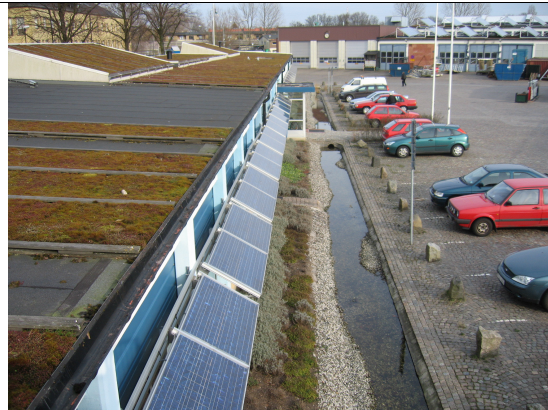
Malmö (S). Doorlatende bestrating, wadi's, groendaken en fotovoltaïsche panelen in de ecowijk Augustenborg . Foto door Erik Rombaut
