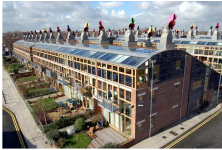
Figuur 9. Elke woning beschikt over een serre die op het zuiden gericht is om passieve zonne-energie op te vangen. (Figuur: BedZED1@greenconstructionuk.wordpress.com )
