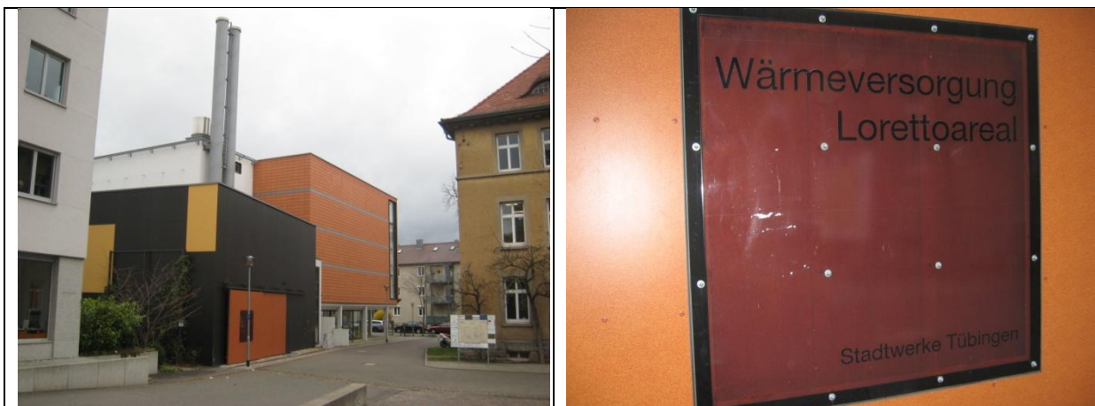
Tübingen (D). In de ecowijk Loretto-areal staat een WKK-centrale die de hele woonwijk van warm water voorziet via stadsverwarming. Foto door Erik Rombaut.
