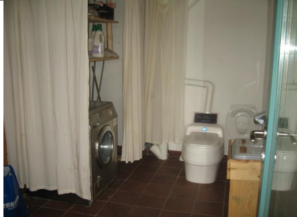
Poppau (D): Composttoilet en gedeelde wasmachine in het ecodorp Sieben Linden . Foto door Erik Rombaut
