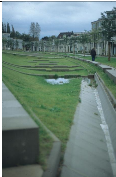
Gelsenkirchen (D). Strak vorm gegeven infiltratie zone in de ecowijk Kuppersbusch . Foto door Erik Rombaut
