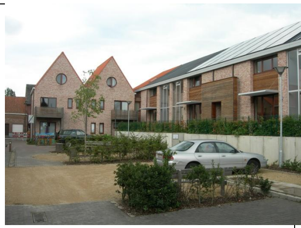
Westerlo (B). 13 sociale laagenergie woningen
