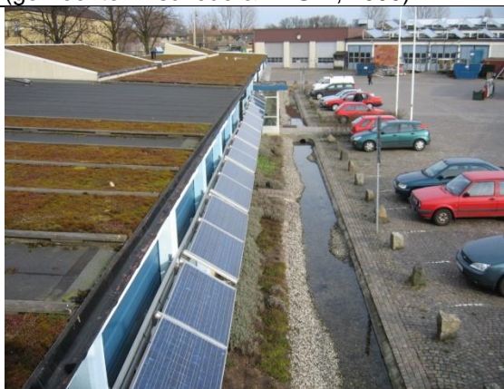
Malmö (S). Vegetatiedaken, doorlaatbare parkeerterreinen en wadi's in de ecowijk Augustenborg . Foto door Erik Rombaut
