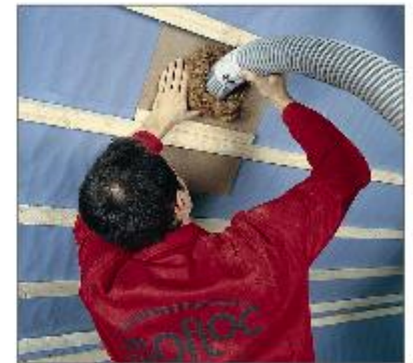
Inblazen van papier isolatie bij het bezoekerscentrum de Bourgoyen te Gent (B)
