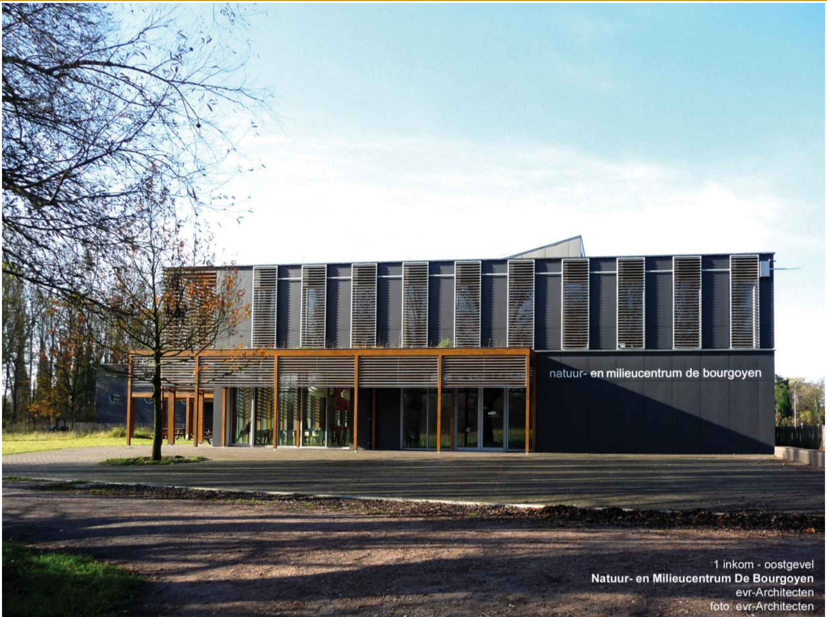
Grondbuizen werden ook toegepast in dit evr-project te Gent (B)
