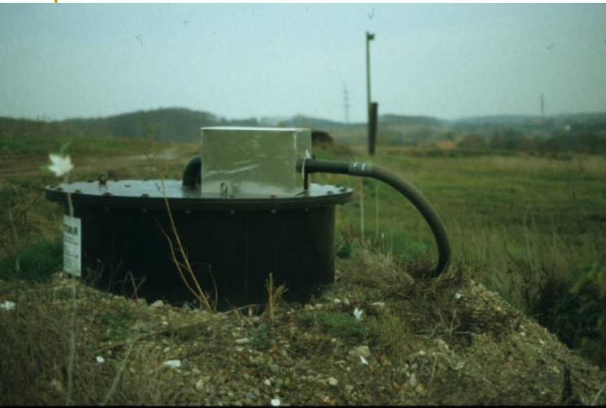
Verzamelen van het stortgas (Pellenberg, B)
