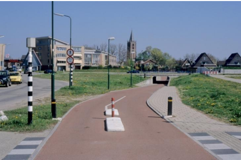
Houten (NL). Veilige aansluiting met het centrum via doorkijk tunnel.
