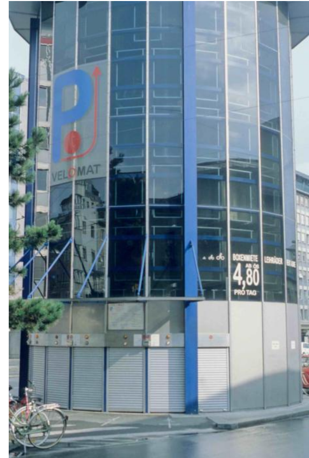
Innsbruck (AT) automatische fietsen stelplaats
