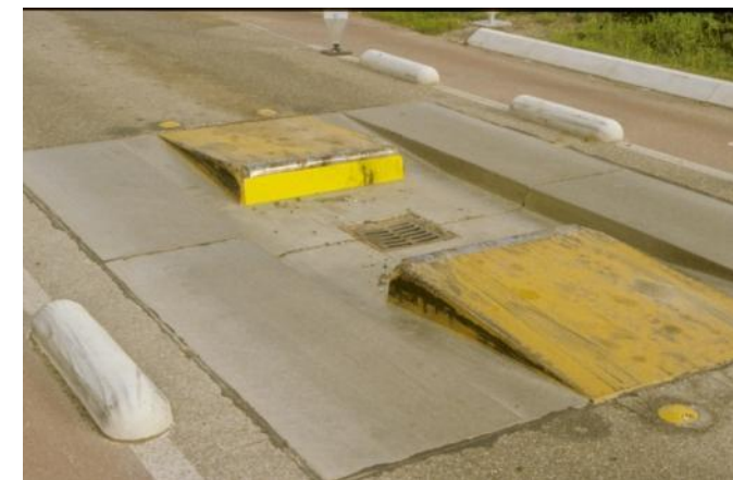
Bussluis in Axel (NL)
