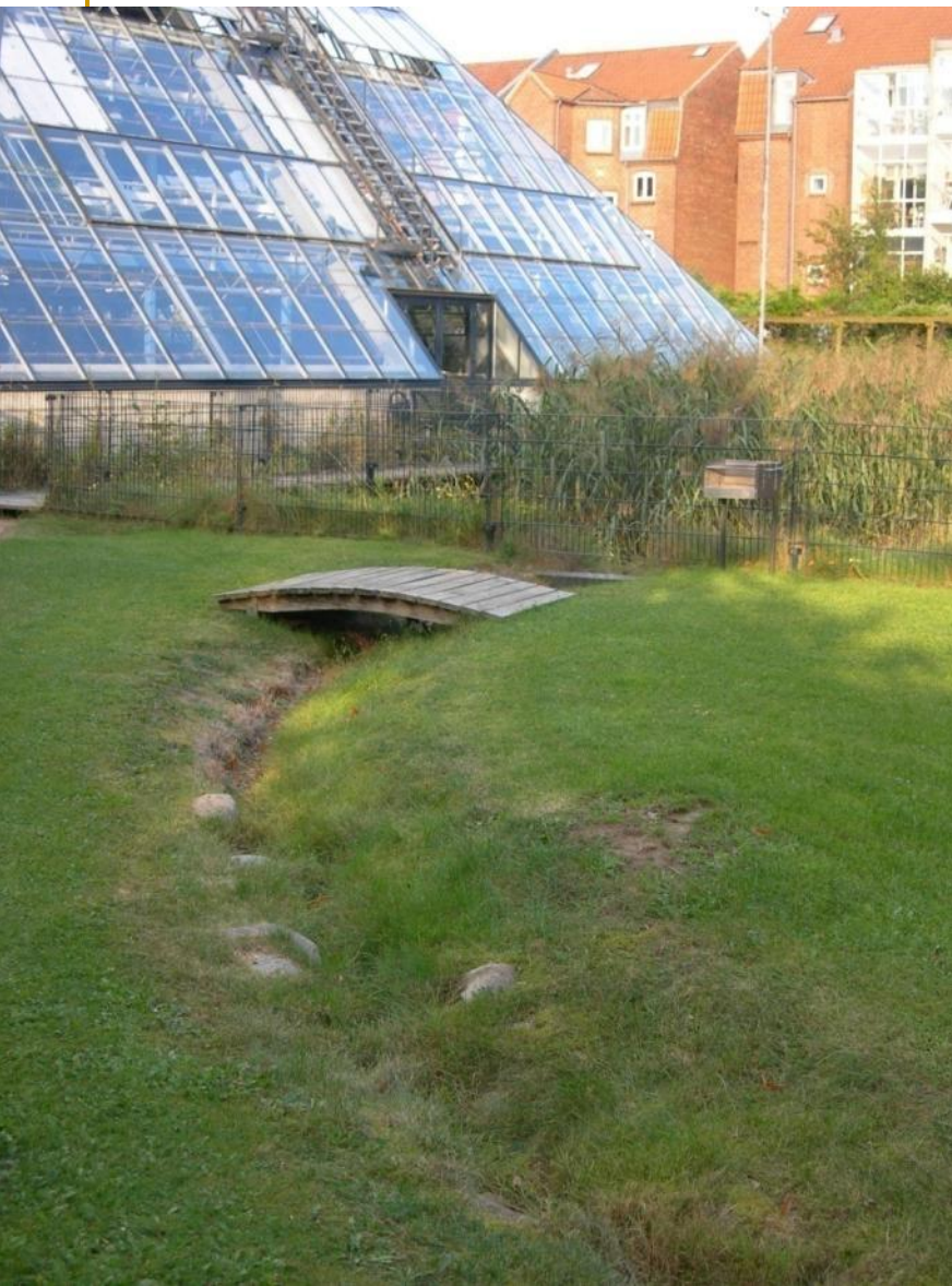
Wadi voor infiltratie van wit water
