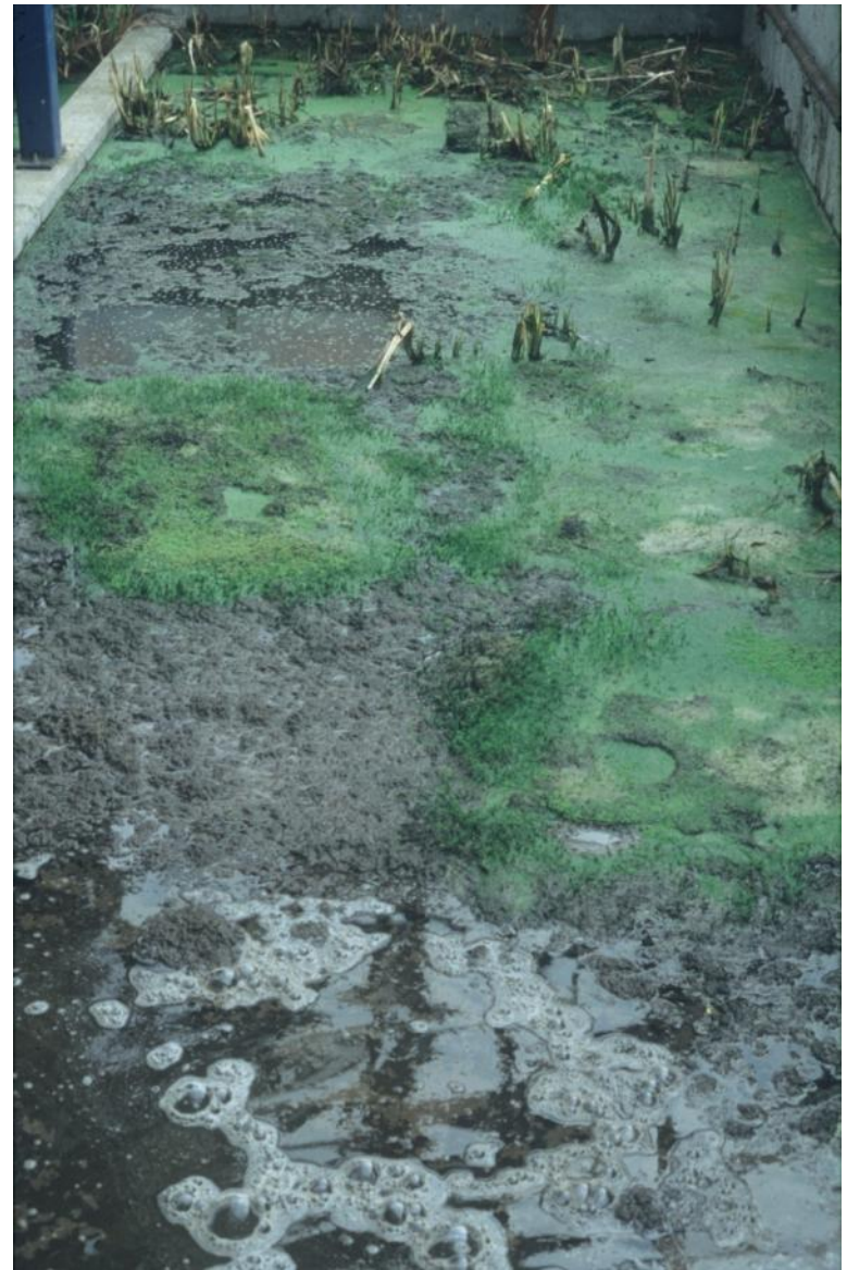
Zwart en grijs water worden gezuiverd in een plantenzuivering
