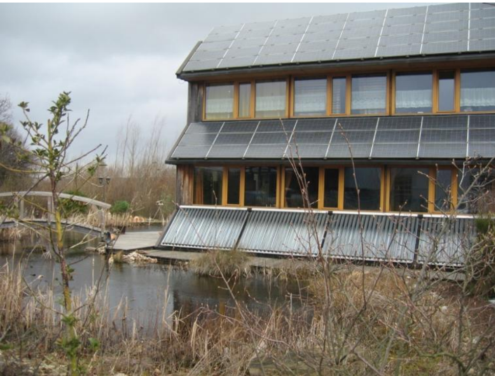
Niederzier (D). EUT Haustechnik
